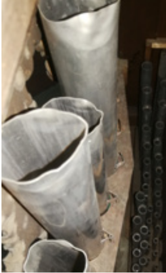
Verformte Metallpfeifen vor der Sanierung
