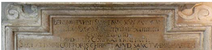
Inschriftenfeld (Zustand während der Restaurierung)
