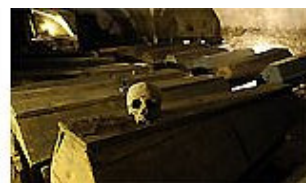
Die Särge in der Michaelergruft waren dem Verfall preisgegeben - eine Belüftungsanlage schafft Abhilfe.
